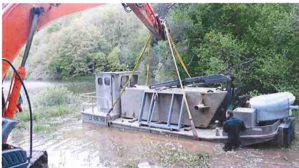
Mise à l'eau de la barge.
