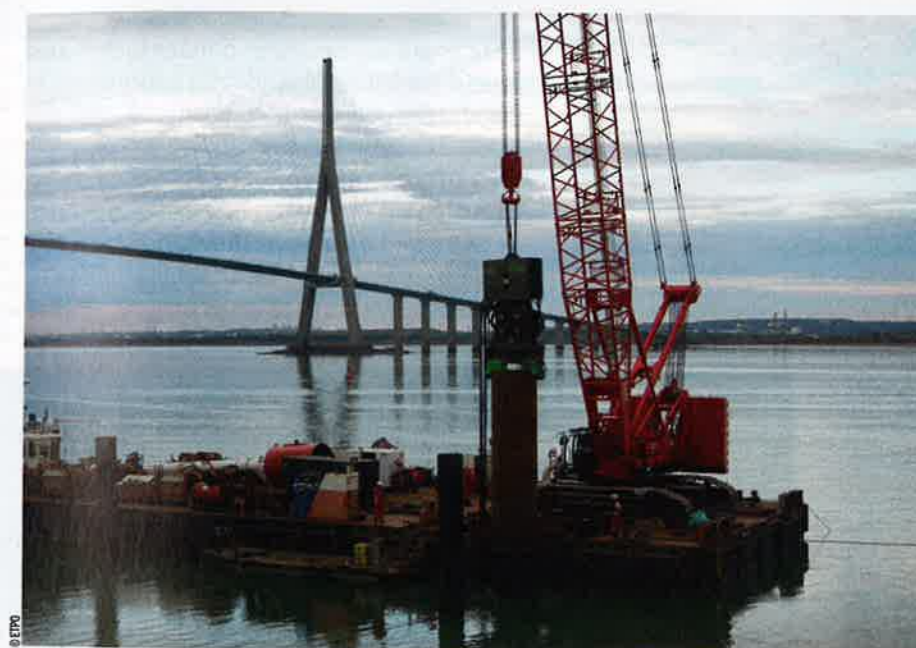
LA CONSTRUCTION DE DUCS-D'ALBE D'ACCOSTAGE A COTE DU HAVRE REQUIERT UN MATERIEL DE POINTE.
